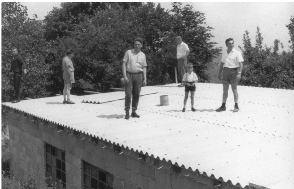
1964 Beim Dachdecken des Aufenthaltsraums
